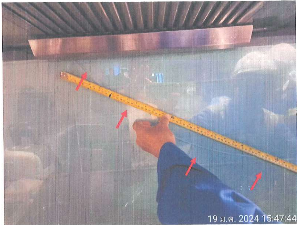
พบกระจกเครื่องดูดควันในห้องครัวแตกร้าว
